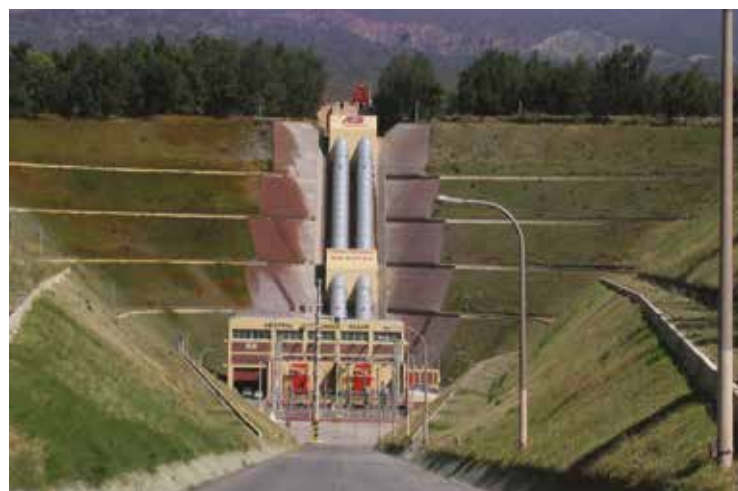
Central hidroeléctrica de Ullum, en la provincia de San Juan. El agua, contenida en un embalse, se hace descender por los tubos que se ven en la imagen y que provoca el giro de las turbinas ubicadas en el edificio.
