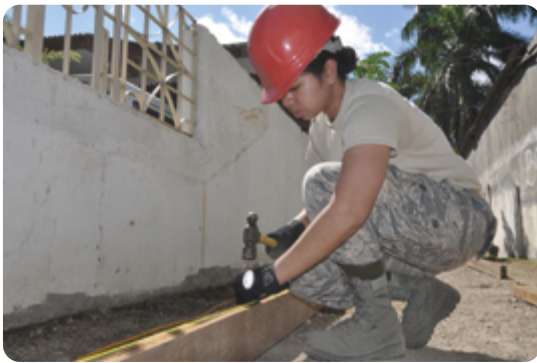
UNA TRABAJADORA PARTICIPA DE UNA OBRA DE CONSTRUCCIÓN.
